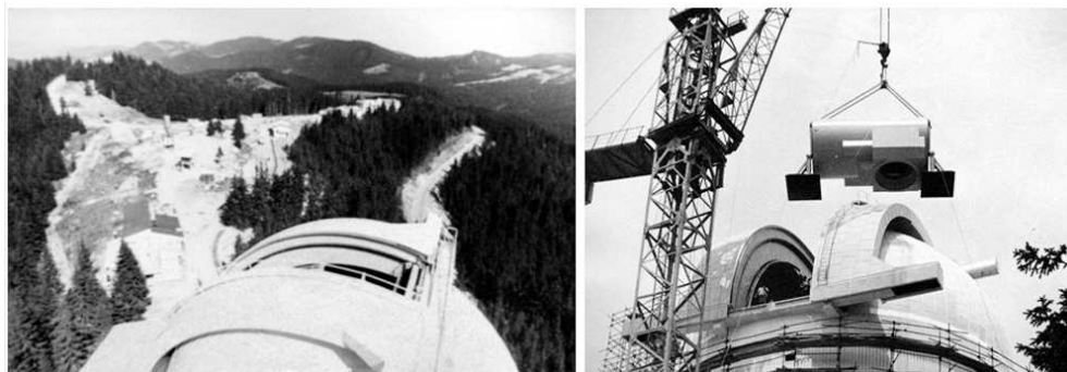
Фиг. 23. Строителната площадка на НАО „Рожен“ (вляво) и монтаж на тубуса на 2-м телескоп (вдясно). (снимки: В. Цинцаров-архив НАО)
