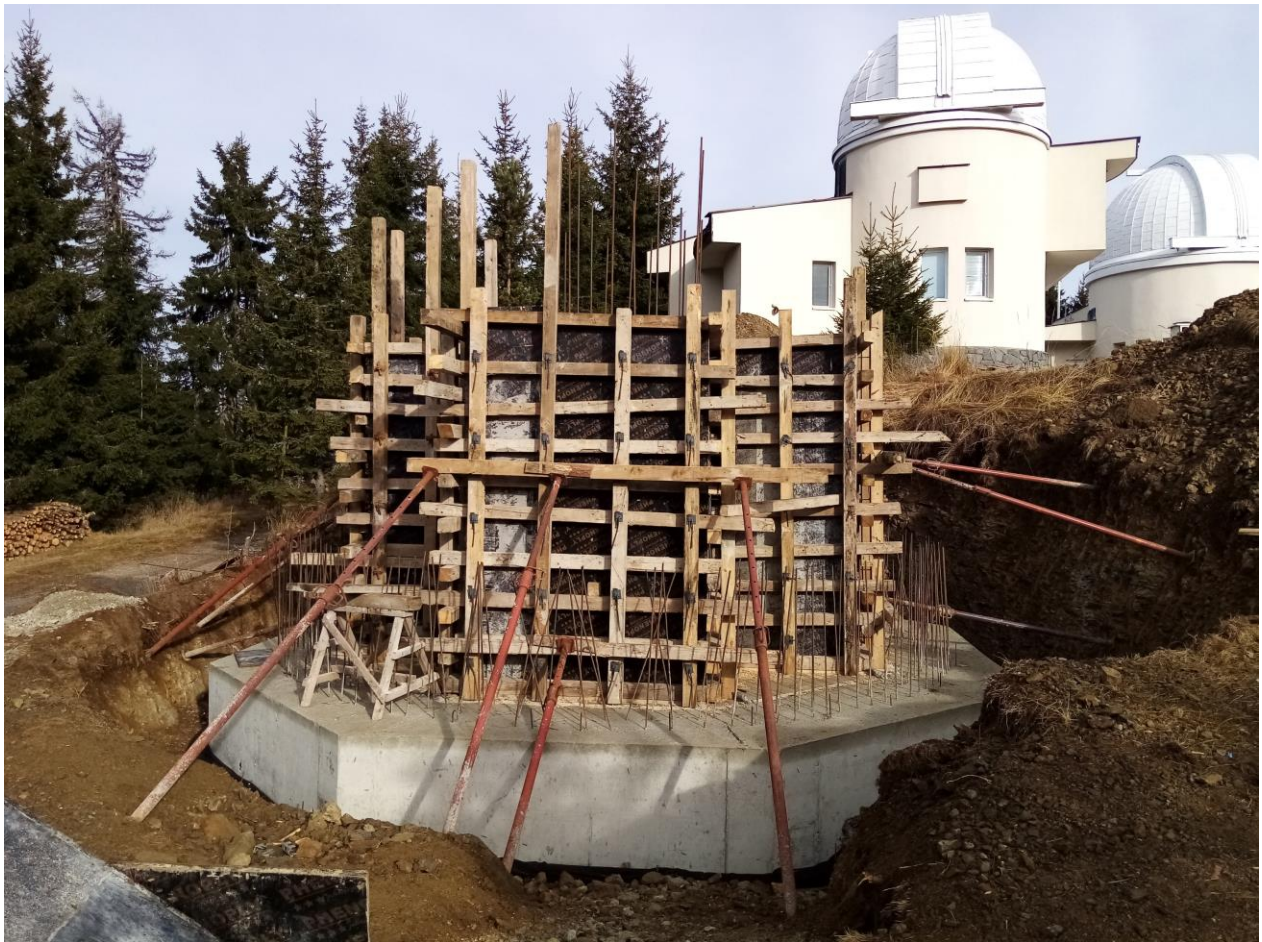
Фундаментът на новия 1.5м телескоп.
